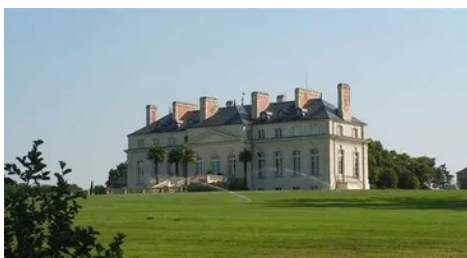
Château du Pont Hus
