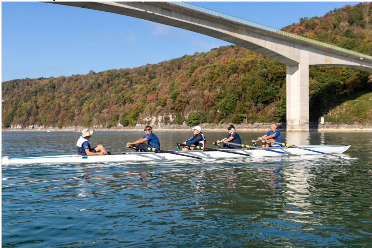
Le Pont La Pyle
